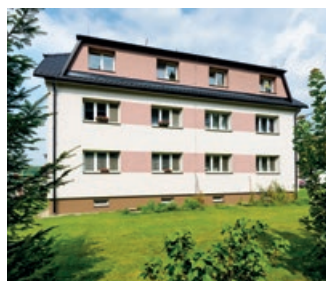
Zateplení bytových domů
